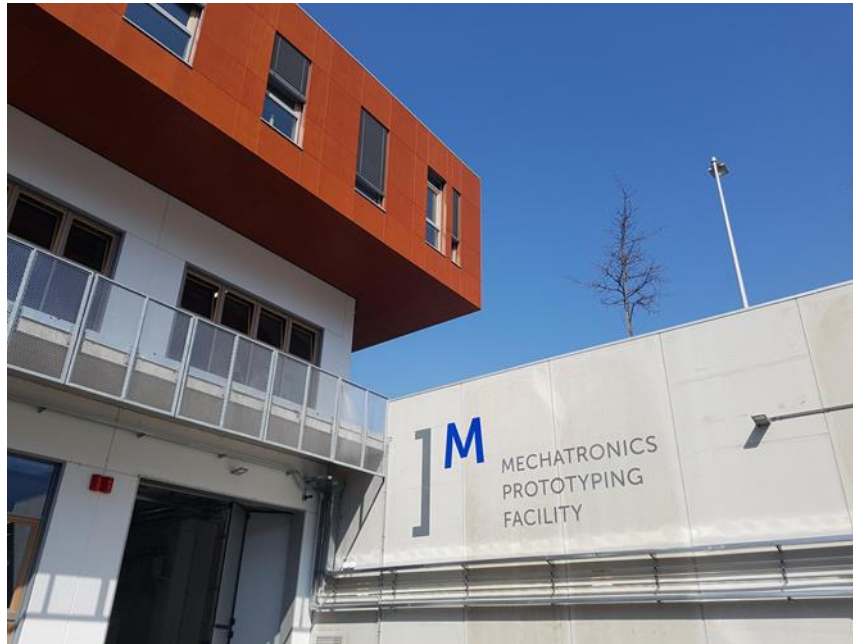
Figura 4. Prom facility- visione esterna
