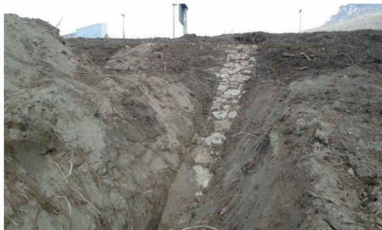
Figura 4. Rivestimento in massi a secco sottostante i depositi del fiume Adige
